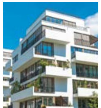
Protection de balcon, immeuble d'habitation
