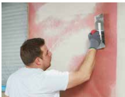
Renforcer des matériaux isolants
