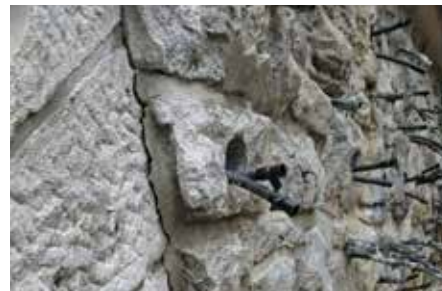
Maçonnerie préparée pour le remplissage
