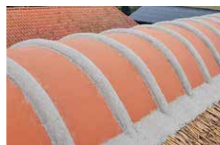
Finition du faîte avec du mortier de couverture FL-D sur un toit recouvert de chaume
