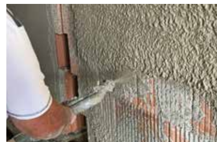
Application d'un FL-P Enduit à la chaux historique avec la machine à crépir
