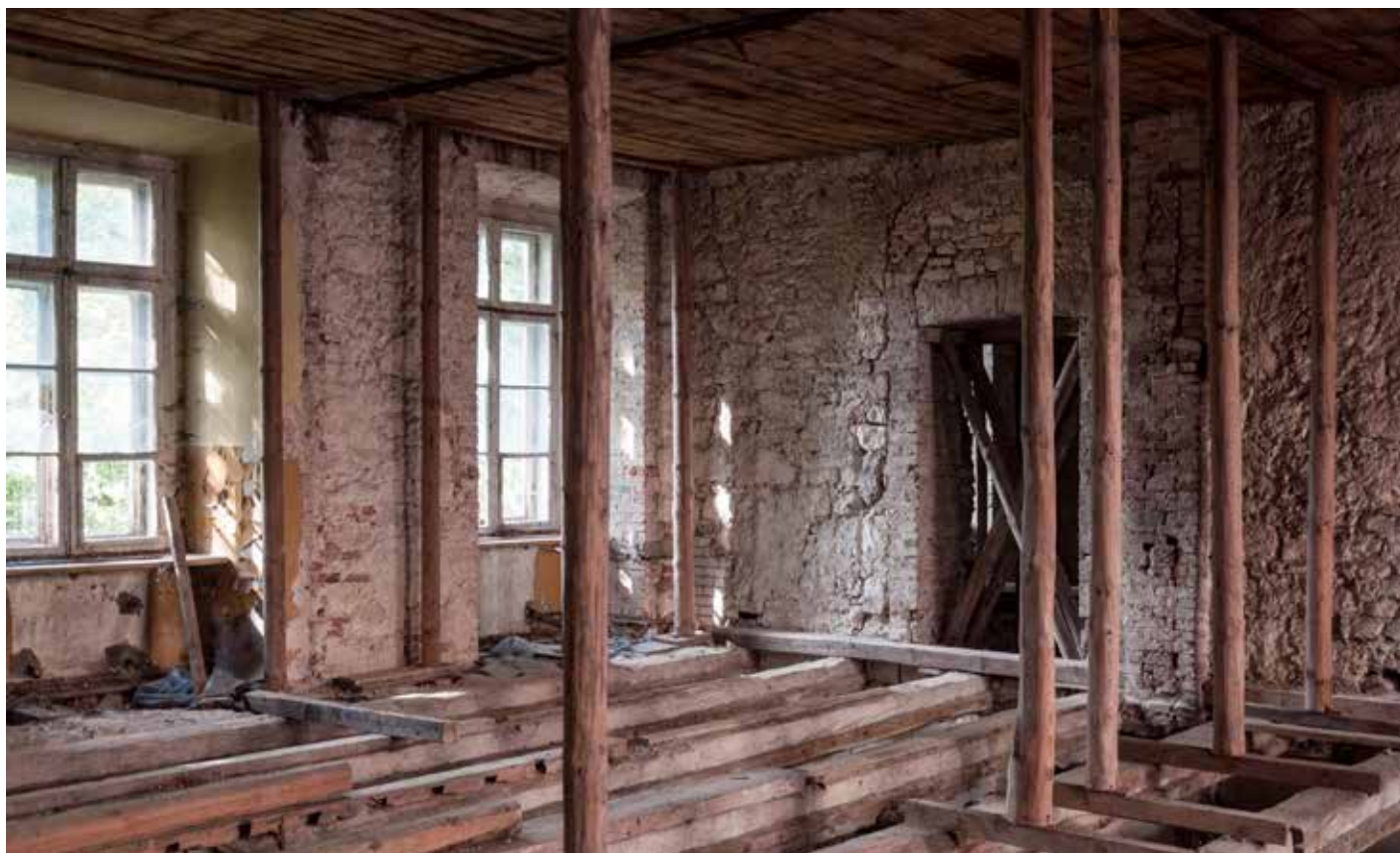
Klassieke houten balkenconstructie in verdieplingsplafonds
