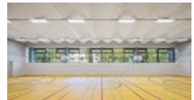
▲ Eine akustisch wirksame Prallwand aus Naturholz zieht sich bis unter die Decke.
