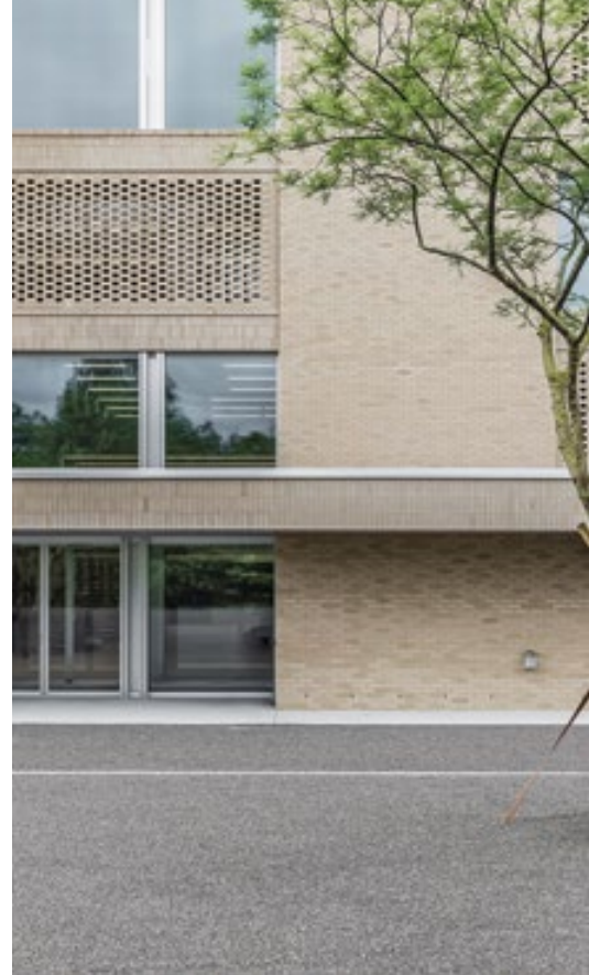
▲ Relief, Filtermauerwerk und Lisenen prägen die Klinkerfassade.
