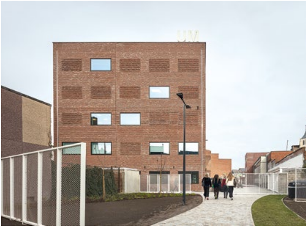
▲ Bei der Nachverdichtung wurden unbebaute Freiflächen großzügig mitgedacht.
