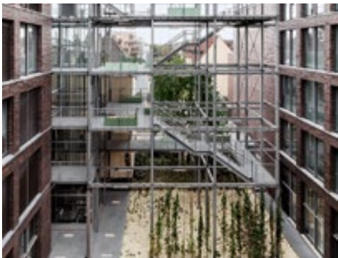
▲ Der vertikale Garten verbindet das Gebäude mit der Stadtöffentlichkeit.
