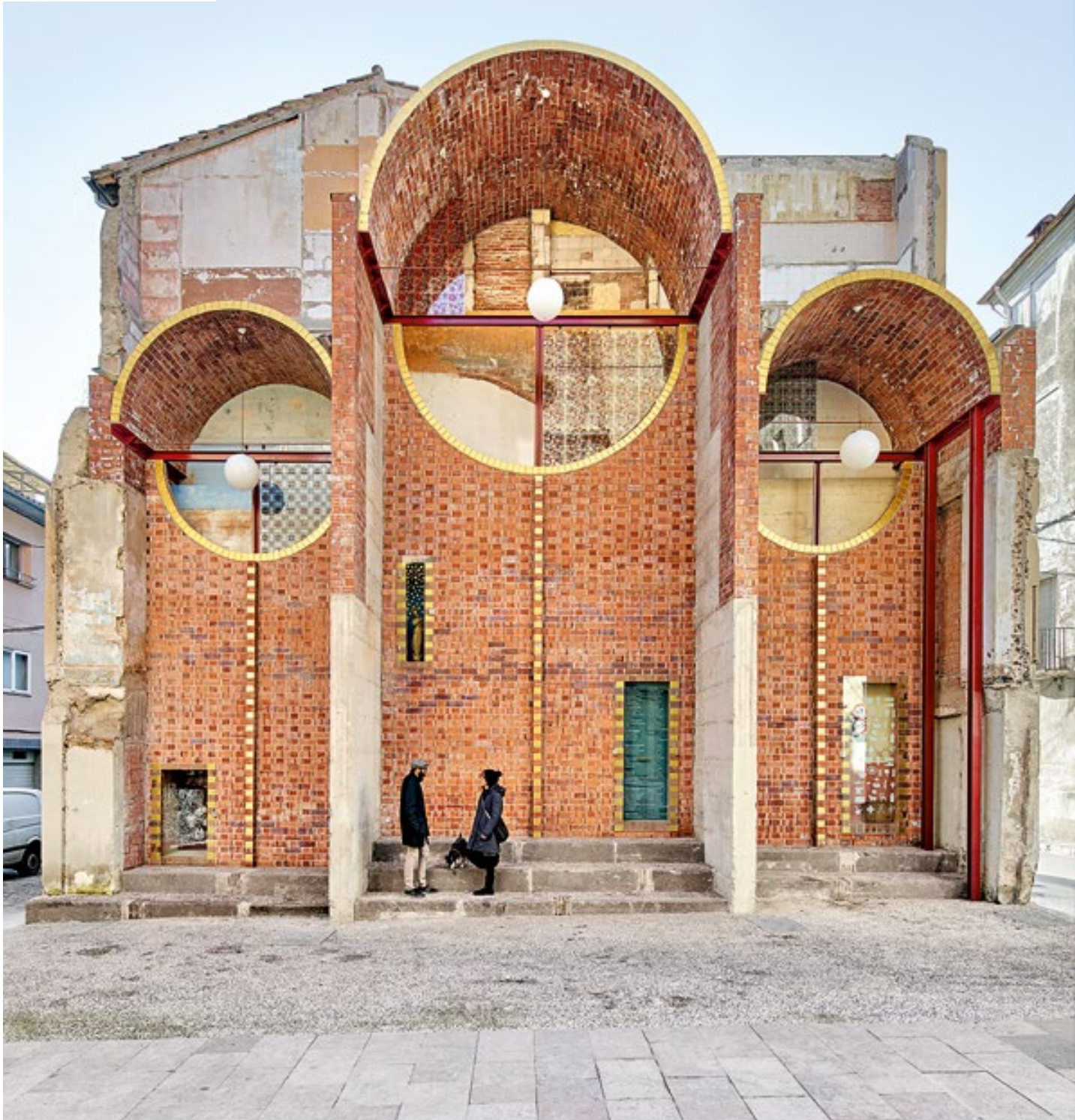
▲ Die Backstein-Gewölbe verleihen dem Abbruchplatz ein neues urbanes Gesicht.
