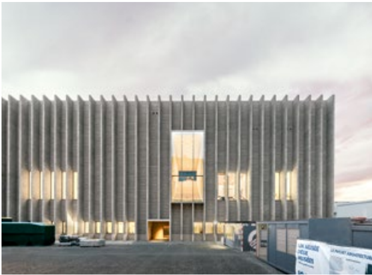
▲ Die pragmatischen Formen und der Erhalt spezifischer Fragmente greifen die industrielle Vergangenheit des Ortes auf.
