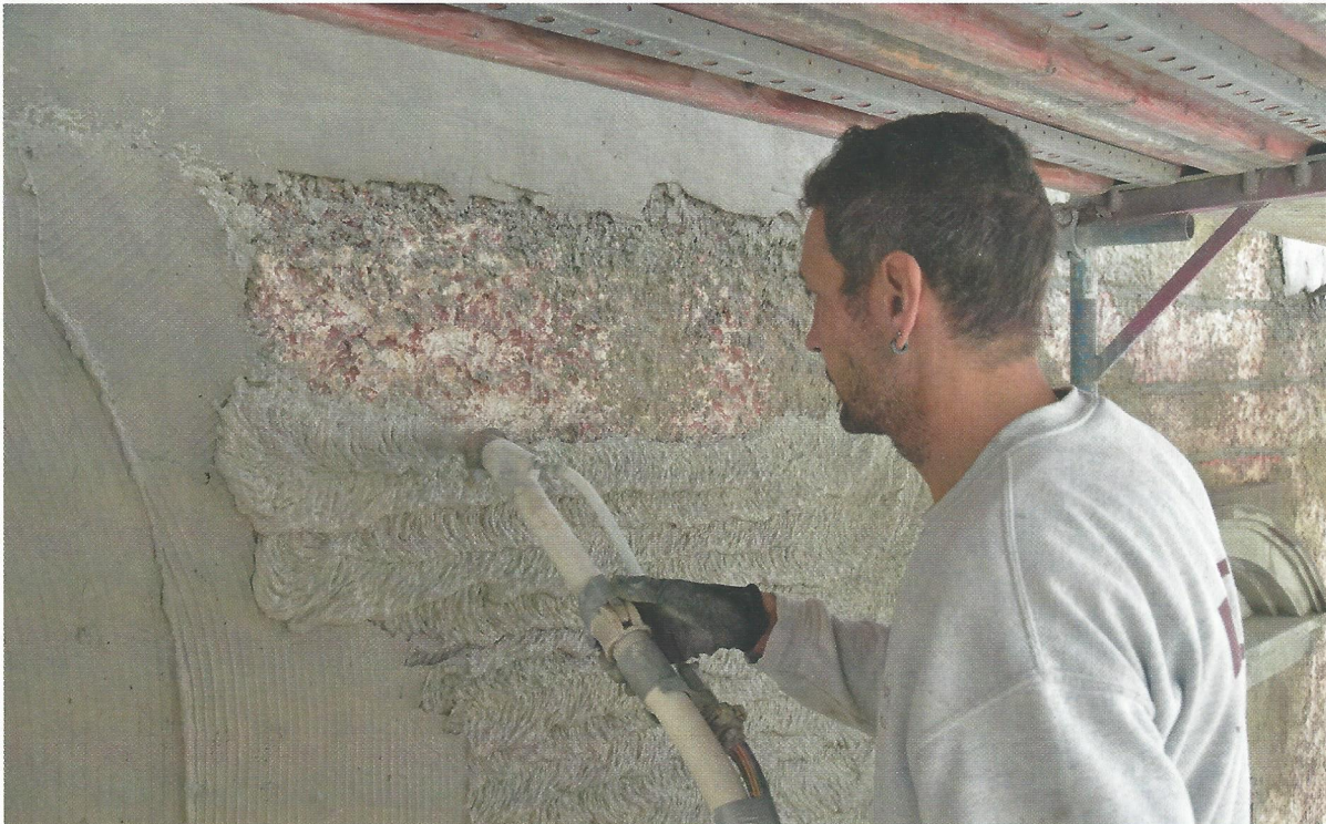
Der ursprüngliche Putz im Bestand war ein leicht hydraulischer Kalkputz. Der ähnlich rezeptierte Trass-Kalk Feuchteregulierungsputz von tubag wurde für die Instandsetzung mit der Putzmaschine aufgebracht Fotos: Guido Wollenberg / tubag
