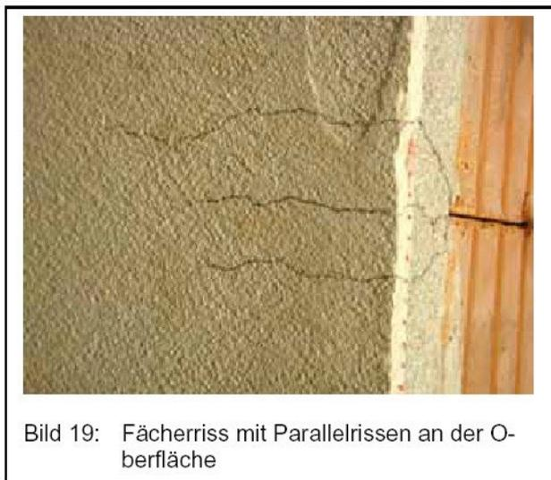
Wesentlich für das Verhalten dieses Putzsystems ist, dass die Summe aller Rissbreiten der an der Putzoberfläche befindlichen Risse im Zustand maximaler Zugbelastung weit geringer war, als die Verbreitung der Stein-fuge und dass alle Risse an der Oberfläche immer noch als Haarrisse bezeichnet werden konnten.
