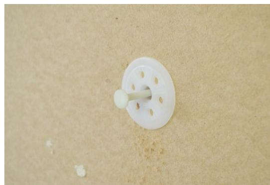
*Bei Bedarf können Schlag- oder Schraubdübel zur mechanischen Befestigung eingesetzt werden*
