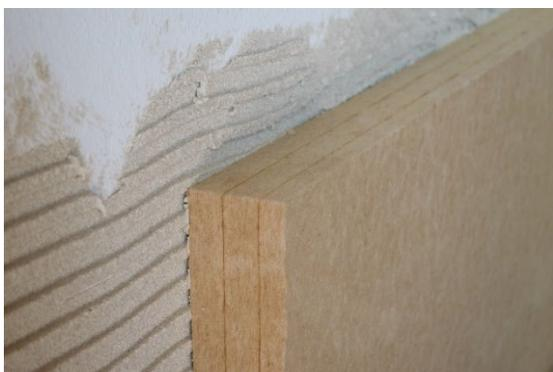
*Einschwimmen der Dämmplatten*
