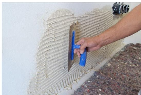
*Buttering-Floating-Verfahren: Vollflächiger Spachtelkleberauftrag kreuzweise auf die Dämmplatte und den Untergrund mittels Zahntraufel.*
