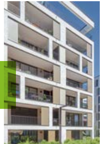
Protection de balcon, immeuble d'habitation
