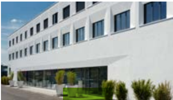
Bâtiment administratif, Jettingen-Schepbach
