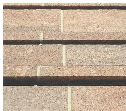
Die Dehnungsfugen im Mauerwerk wurden mäandrierend ausgeführt, um zu verhindern, dass der Stein bricht.
