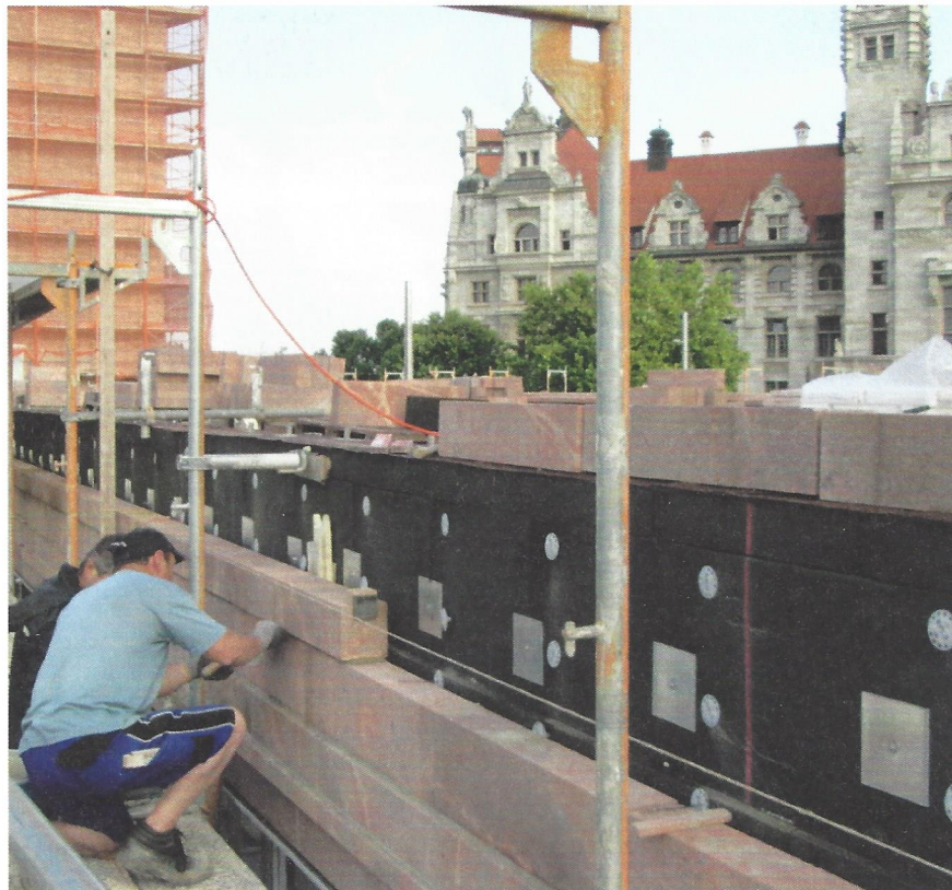
Mitarbeiter der FX Rauch GmbH beim Versetzen von Steinen am Kirchenneubau in Leipzig
