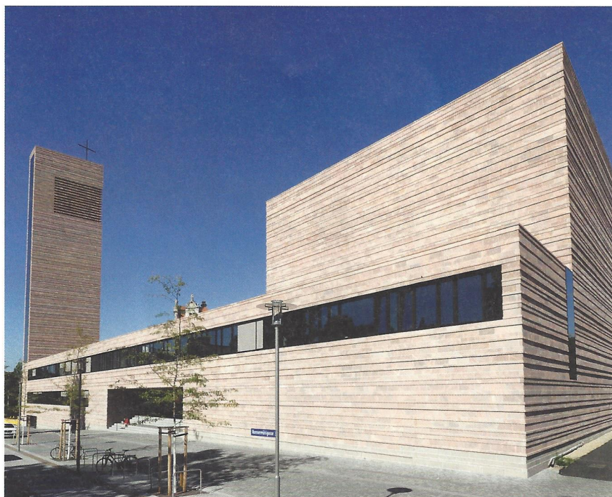
Die Dehnungsfugen im Mauerwerk wurden mäandrierend ausgeführt, um zu verhindern, dass der Stein bricht.
