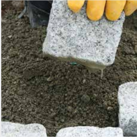
Placer et marteler l'élément de revêtement dans le mortier de pose frais (par exemple, tubag TPM-D4).
