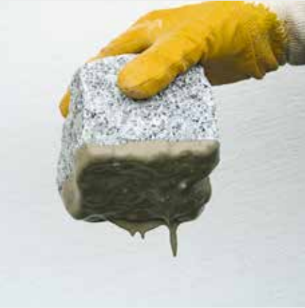
Recouvrir généreusement l'élément de revêtement de barbotine d'adhérence.
