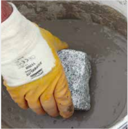
Plonger l'élément de revêtement dans la barbotine d'adhérence. Une autre alternative consiste à en enduire la face inférieure.
